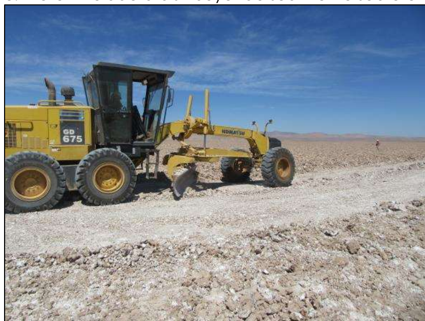
Figura 28. Moto niveladora distribuyendo sedimento sobre el camino.
