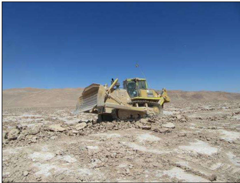
Figura 47. Bulldozer moliendo material sedimentario sobre camino de servicio.
