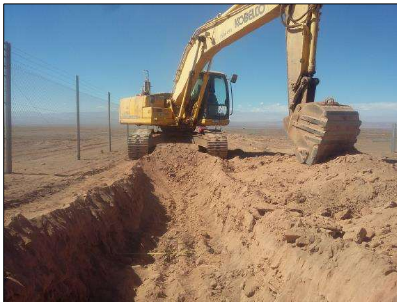
Figura 35. Parcela Oriente, ZSEG 02. Excavadora en proceso de excavación de zanja.
