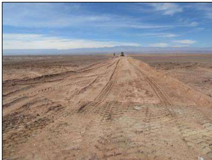
Figura 18. Sector Plataforma Subestación. Camino de acceso tras la intervención de motoniveladora.
