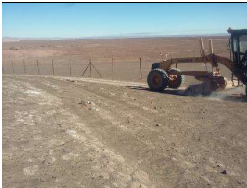
Figura 33. Camino LAT. Motoniveladora en labores de escarpe sobre camino intervenido previo a la instalación del Proyecto GS.
