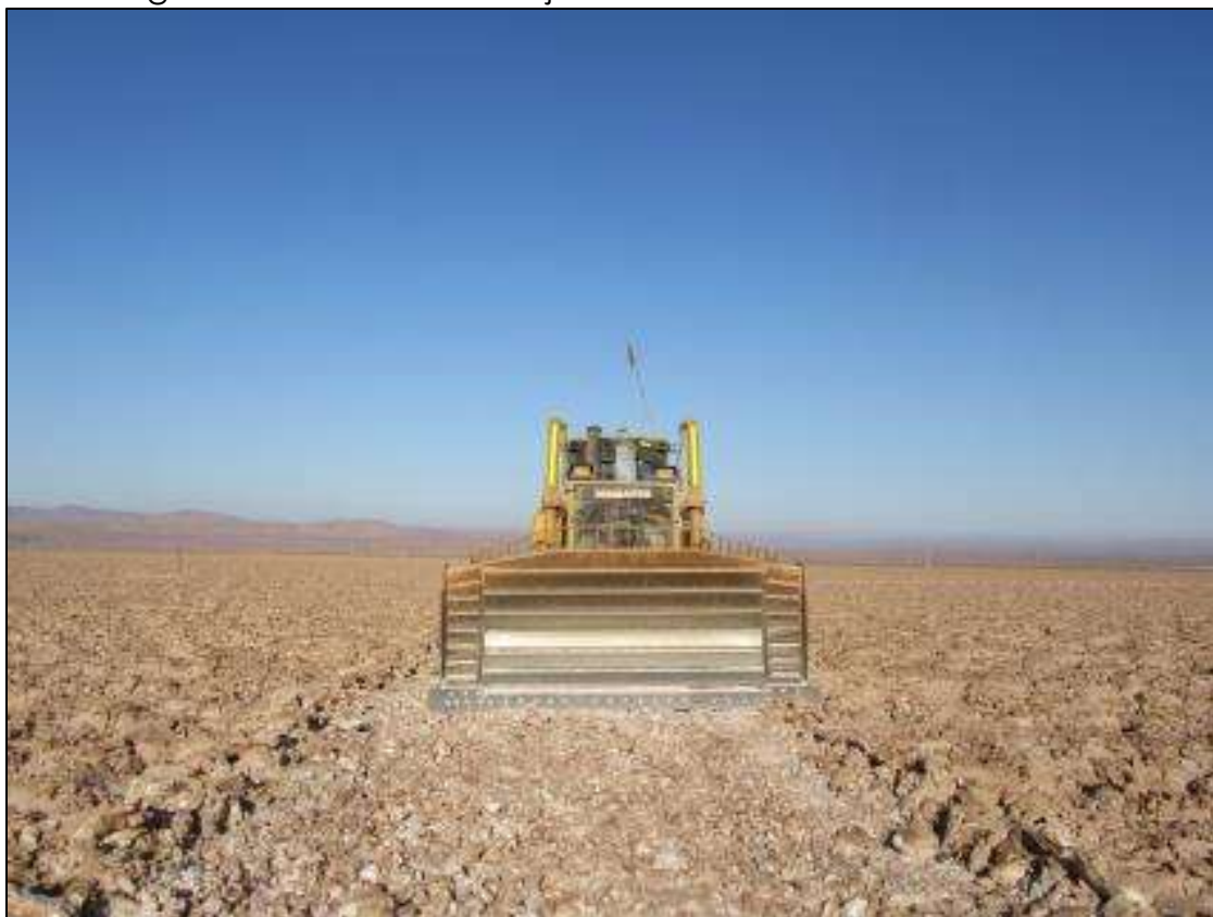
Figura 19. Bulldozer trabajando en camino de servicio LAT.
