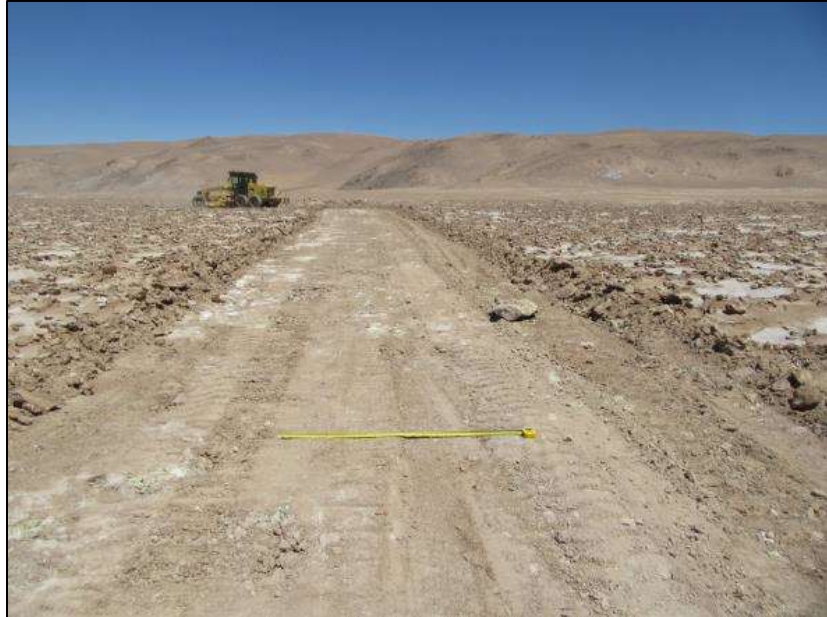
Figura 37. Avance constructivo camino de servicio para LAT.
