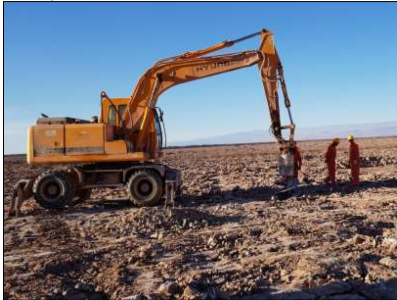
Figura 28. Camino LAT. Excavación Torre 26.
