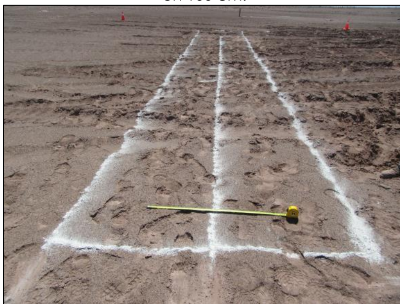
Figura 37. Parcela Oriente GS. Demarcación zanja a excavar. Flexómetro en 100 cm.
