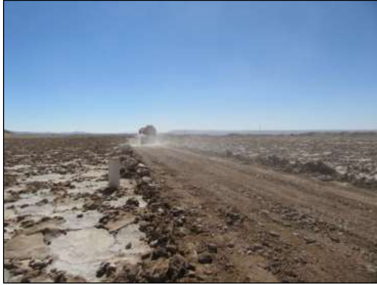
Figura 40. Camión aljibe humectando camino de servicio.
