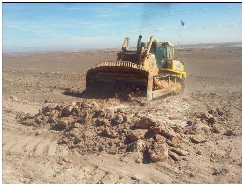
Figura 29. Camino LAT. Bulldozer en proceso de construcción de camino de servicio.
