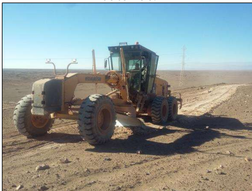
Figura 32. Camino LAT. Motoniveladora en proceso de escarpe de camino de servicio.
