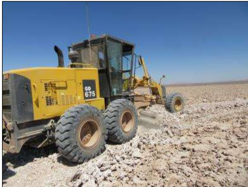
Figura 24. Moto niveladora interviniendo suelo para construcción de camino.
