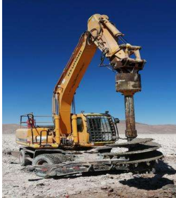
Figura 3. Perforación Torre 02. Sector LAT, Tramo 01.
