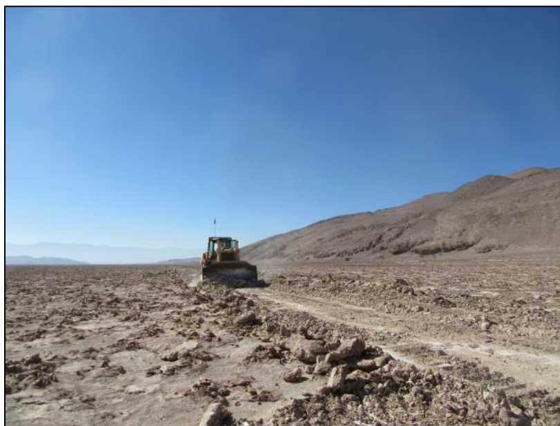
Figura 34. Camino de servicio en LAT. Bulldozer distribuyendo material sobre huella construida.
