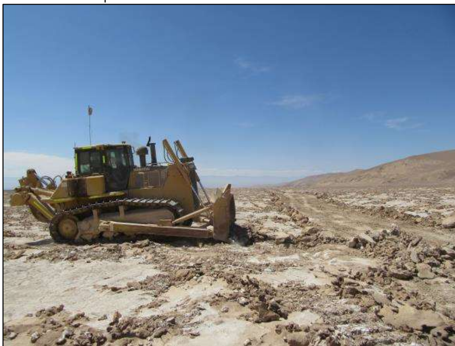
Figura 49. Bulldozer aportando material sedimentario a camino de servicio.
