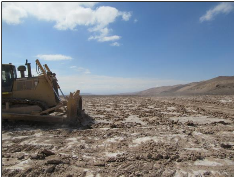
Figura 9. Bulldozer realizando aporte de material sedimentario al eje del camino de servicio en LAT.
