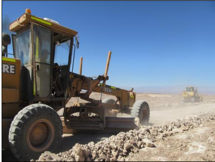
Figura 24. Motoniveladora distribuyendo material sedimentario sobre la superficie.
