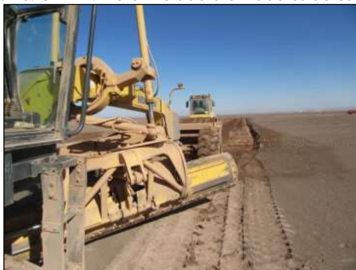
Figura 13. Ctin 12. Motoniveladora en labores de escarpe.
