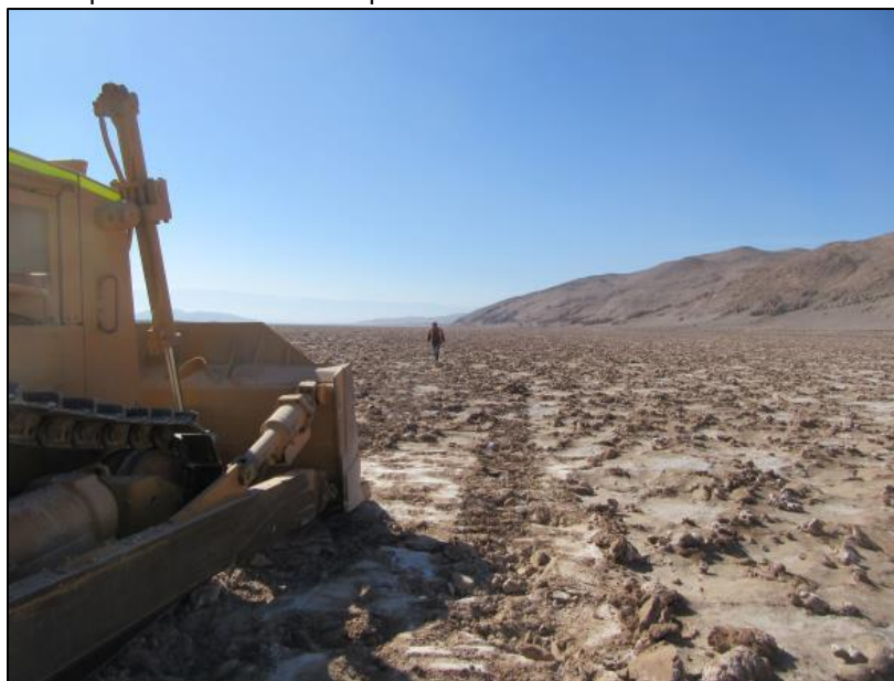
Figura 31. Camino de servicio en LAT. Bulldozer construyendo nueva huella. Al fondo operador de maquinaria revisando el trazado a seguir.
