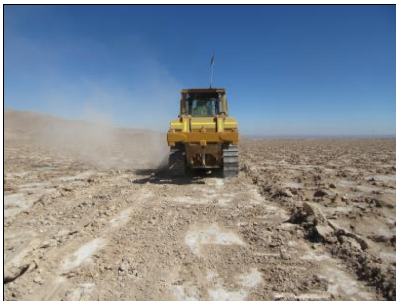
Figura 30. Camino de servicio en LAT. Bulldozer generando escarpe sobre el suelo natural.
