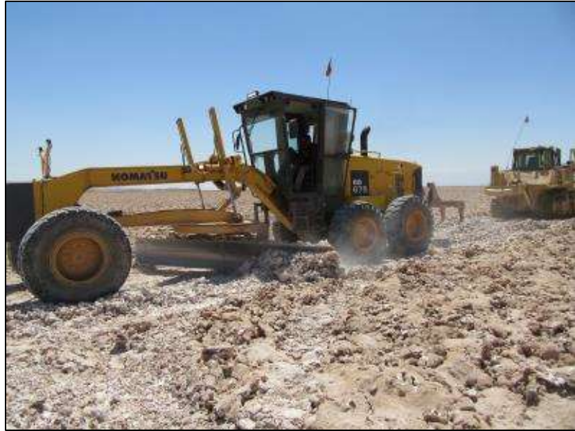
Figura 23. Moto niveladora perfilando contornos del camino de servicio LAT.
