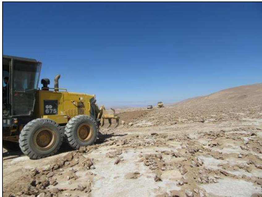
Figura 38. Moto niveladora aportando material sedimentario al camino. Al fondo, Bulldozer en mantenimiento.
