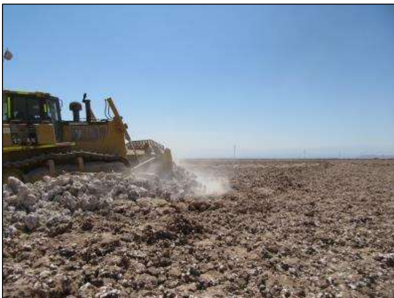
Figura 31. Bulldozer interviniendo suelo natural para construcción de camino.
