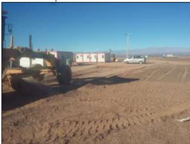
Figura 23. Sector IIFF Oficinas Solarpack. Motoniveladora en labores de escarpe de estacionamiento.
