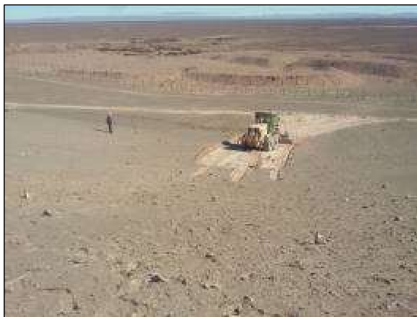
Figura 34. Camino LAT. Motoniveladora en labores de escarpe de acceso a Torre 46.
