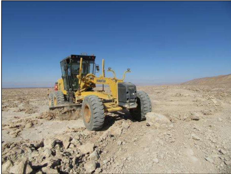
Figura 43. Moto niveladora aportando material sedimentario al camino.
