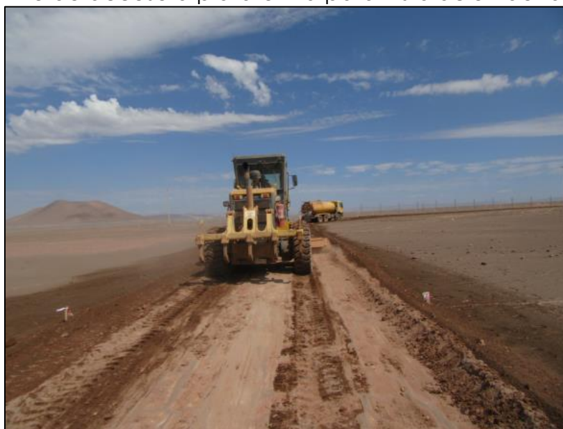
Figura 6. Motoniveladora y camión aljibe en proceso de construcción camino de acceso a plataforma para instalación de faena.
