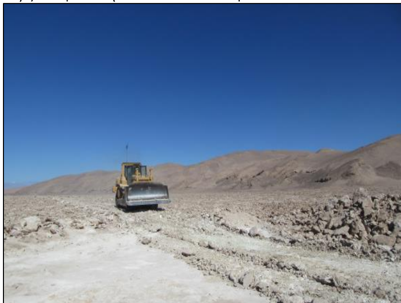
Figura 23. Camino de servicio en LAT. Bulldozer interviniendo sector de cantera en desuso. Se puede apreciar el contraste entre las Capa I (al fondo) y Capa VI (sedimento más próximo de color Blanco).
