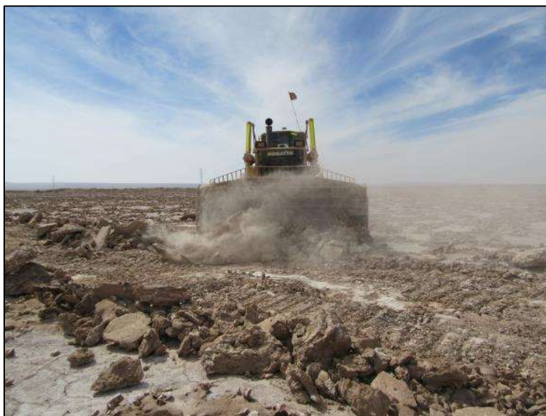
Figura 31. Bulldozer operando para aporte de material a camino de servicio.
