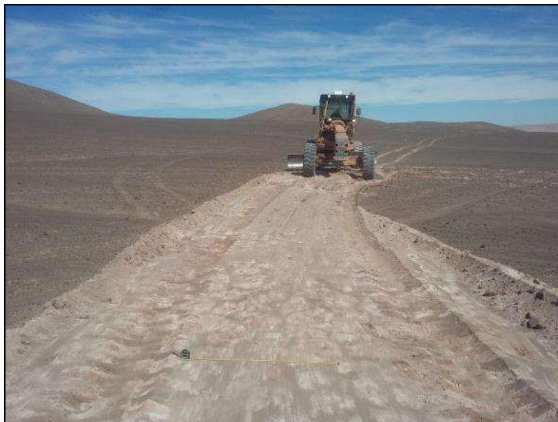
Figura 31. Camino LAT. Motoniveladora en proceso de escarpe de camino de servicio.
