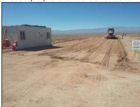
Figura 25. Sector IIFF Oficinas Solarpack. Motoniveladora en labores de escarpe plataforma de residuos.
