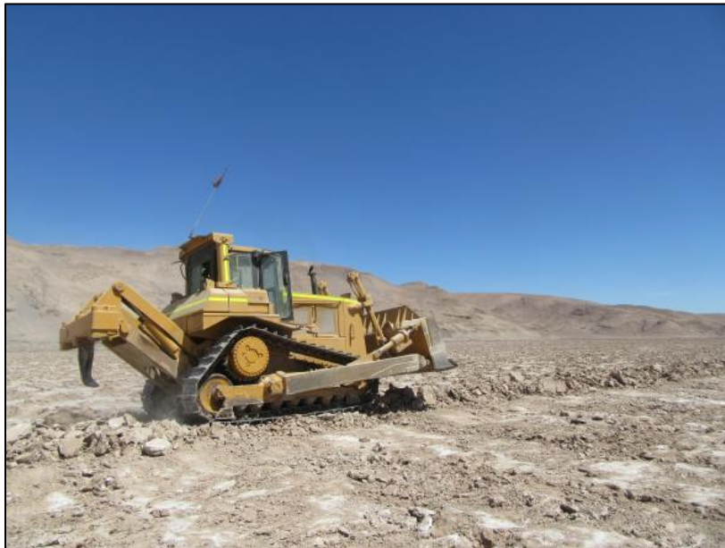
Figura 26. Camino de servicio en LAT. Bulldozer pulverizando aporte sedimentario sobre la huella.
