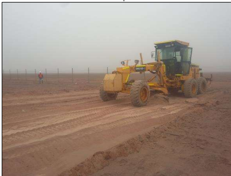
Figura 16. Sector Plataforma Subestación. Motoniveladora en labores de escarpe.
