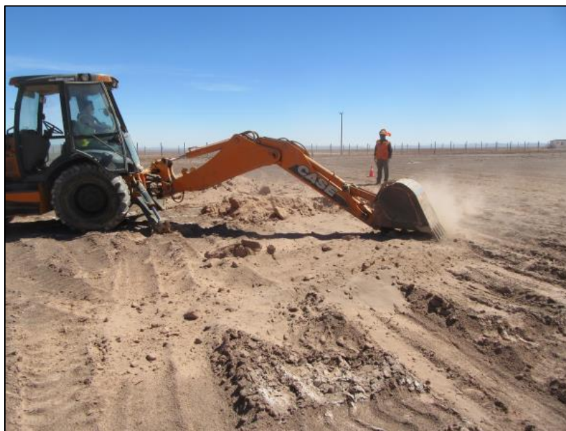
Figura 39. Parcela Oriente GS. Retroexcavadora distribuyendo sedimento excavado sobre la superficie. En la imagen el supervisor de terreno de Alianza S.A.
