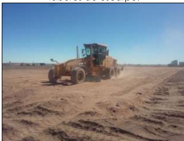
Figura 22. Sector Plataforma Subestación. Motoniveladora realizando labores de escarpe.
