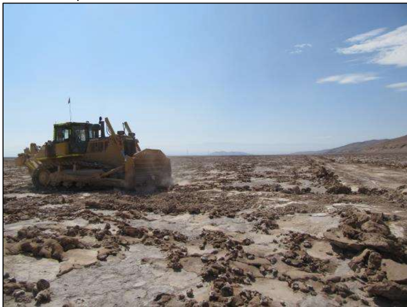
Figura 53. Bulldozer aportando material sedimentario al camino de servicio.
