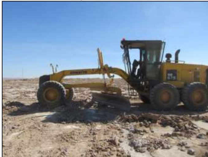
Figura 41. Moto niveladora mejorando superficie del camino avanzado.
