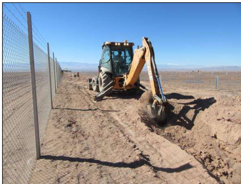
Figura 36. Parcela Oriente, ZSEG 02. Retroexcavadora en proceso de excavación de zanja.
