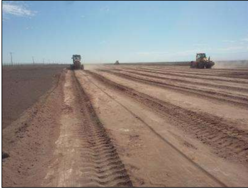
Figura 7. Plano general labores en campá. A la derecha de la imagen se aprecia rodillo compactador en área central de campá y a su izquierda motoniveladora en área poniente.
