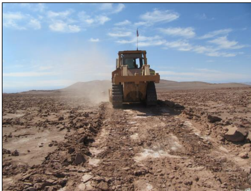
Figura 54. Camino de servicio en LAT. Avance constructivo del Bulldozer.
