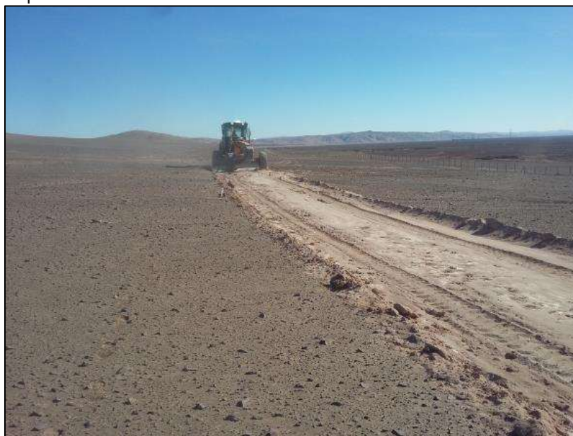
Figura 30. Camino LAT. Motoniveladora reemplazando a Bulldozer en proceso de construcción de camino de servicio.
