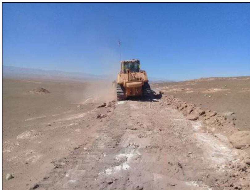
Figura 20. Camino LAT. Bulldozer en proceso de construcción de camino de servicio.
