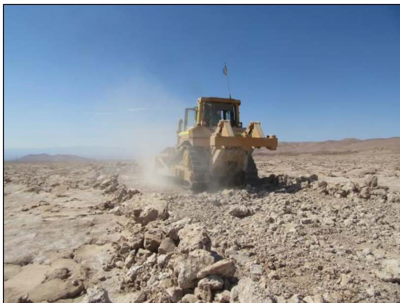
Figura 50. Camino de servicio en LAT. Bulldozer nivelando camino.
