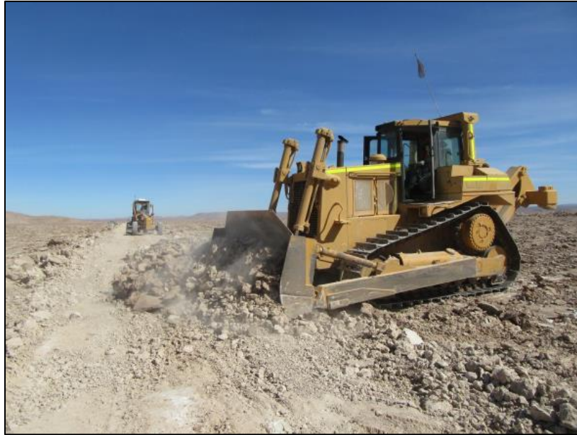
Figura 19. Camino de servicio en LAT. Bulldozer y Motoniveladora al fondo, aportando y distribuyendo material sedimentario sobre el camino.
