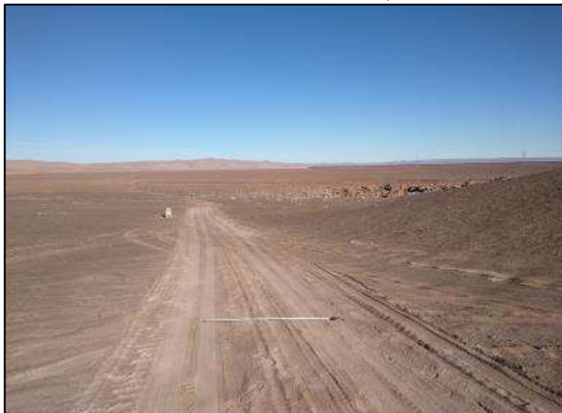
Figura 2. Faldeo Oeste de Cerro Gordo. En la imagen se aprecia el paso del rodillo y huellas vehiculares pre-existentes. Camino de servicio en LAT, vista Oeste. Flexómetro a 150 cm.
