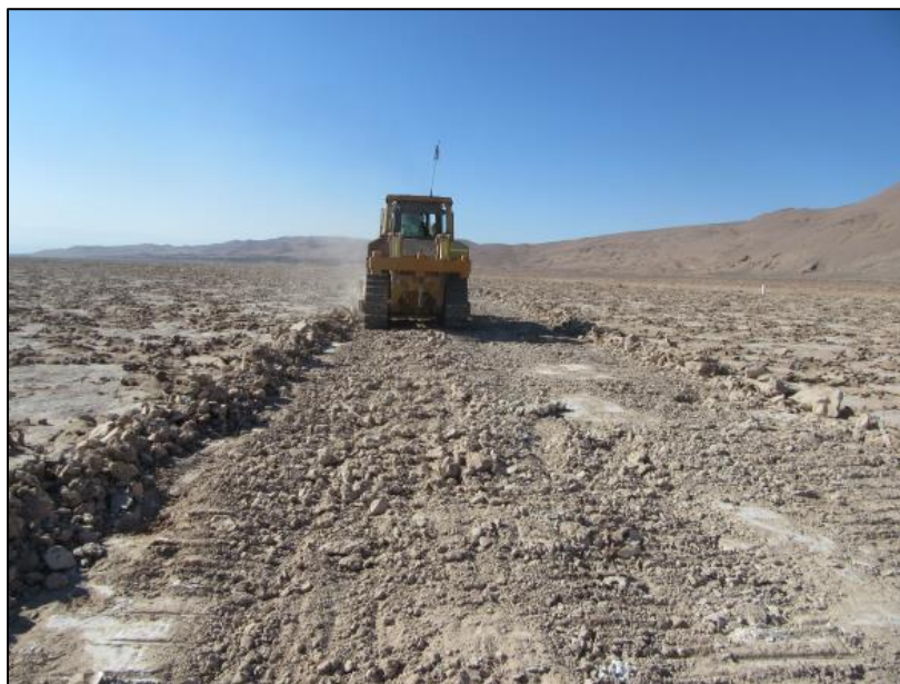
Figura 47. Camino de servicio en LAT. Bulldozer interviniendo suelo natural.
