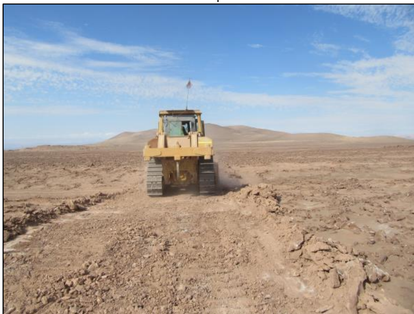
Figura 55. Camino de servicio en LAT. Avance constructivo del camino. Bulldozer operando.
