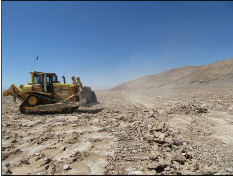
Figura 25. Camino de servicio en LAT, vista este. Bulldozer aportando material sedimentario.
