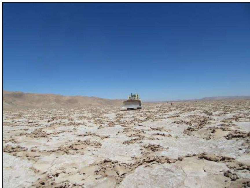
Figura 34. Bulldozer interviniendo suelo natural para construcción de camino.
