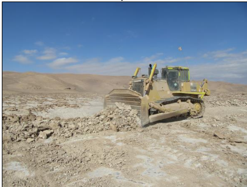
Figura 11. Camino de servicio en LAT. Bulldozer realizando aporte de material al eje del camino.
