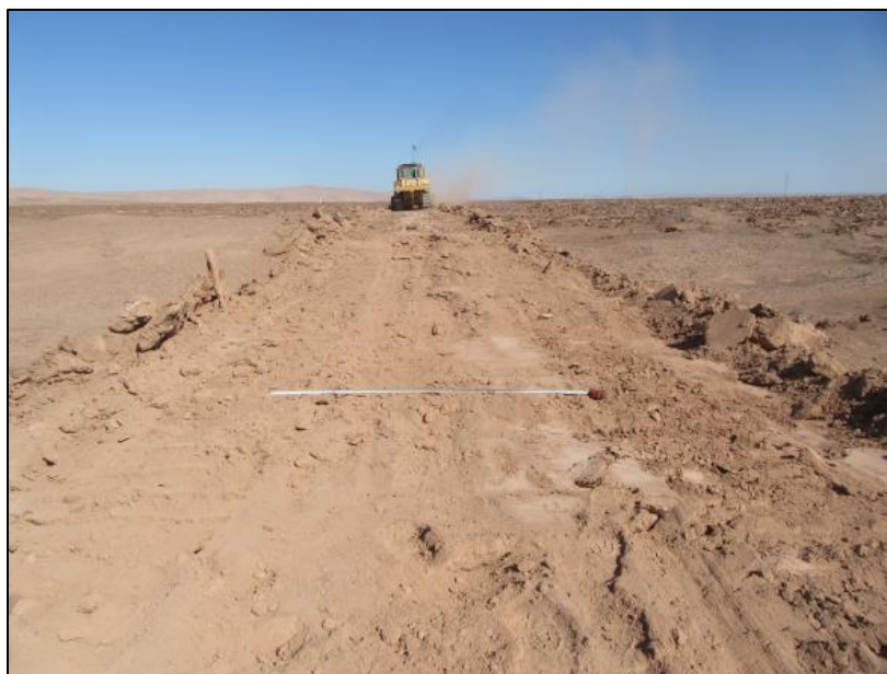
Figura 53. Camino de servicio en LAT. Avance constructivo del camino.
