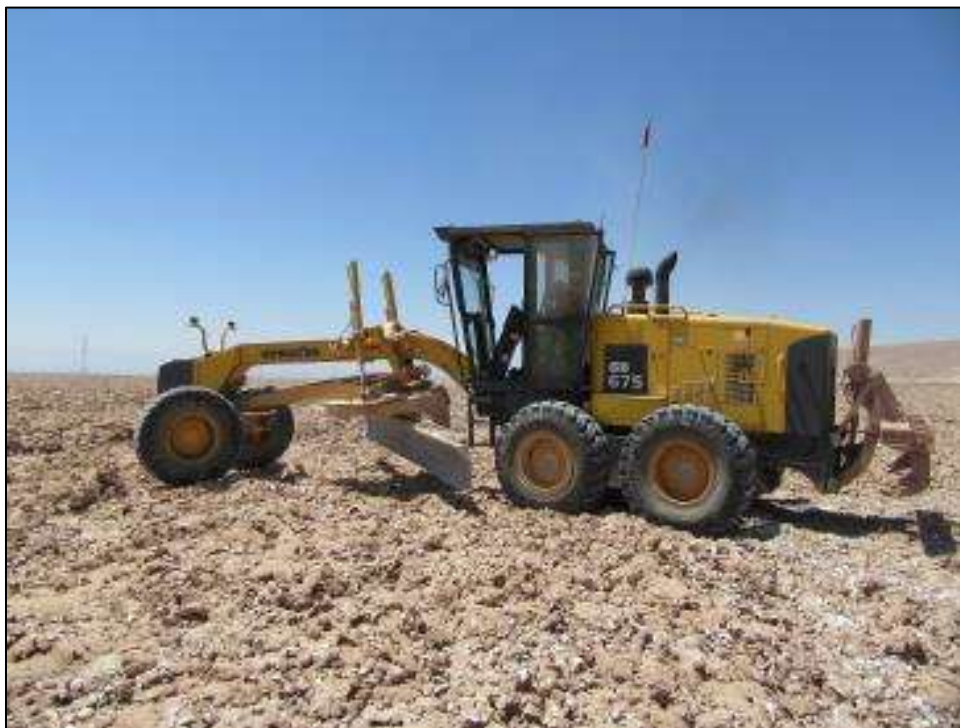
Figura 28. Moto niveladora interviniendo suelo para construcción de camino.
