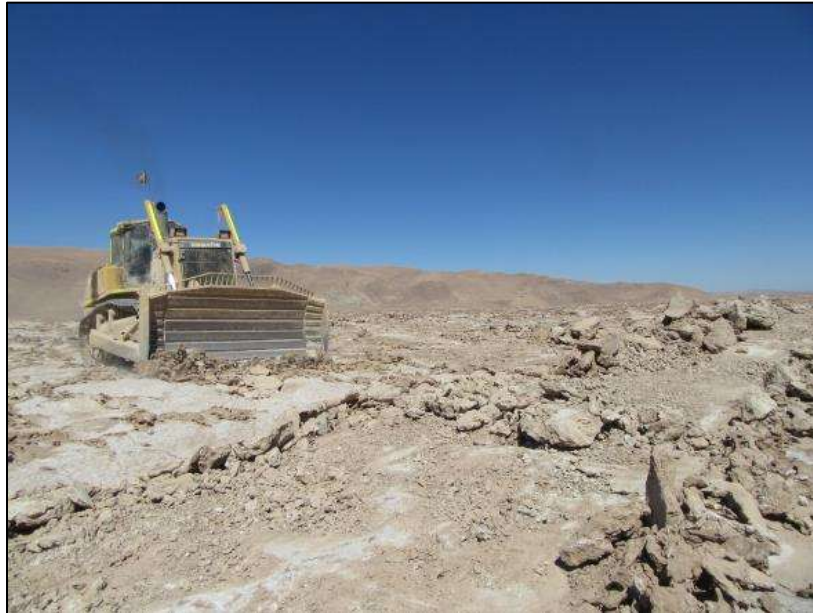
Figura 35. Bulldozer aportando material sedimentario a camino de servicio.
