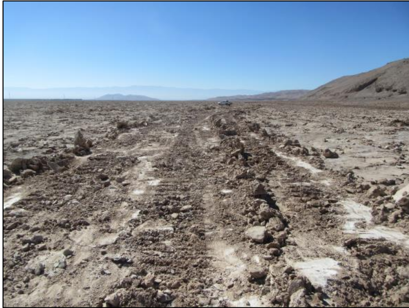
Figura 33. Camino de servicio en LAT. Avance constructivo del camino por Bulldozer con pretil de material sedimentario a distribuir.
