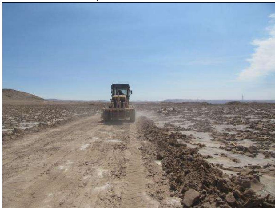
Figura 50. Moto niveladora distribuyendo material sedimentario sobre la superficie del camino.
