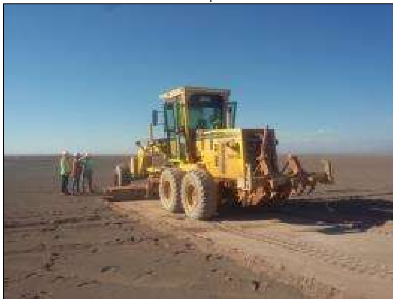
Figura 12. Sector Plataforma Subestación. Motoniveladora en labores de escarpe.
