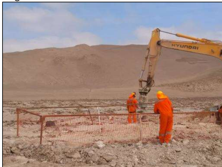
Figura 19. Camino LAT. Perforación Torre 18.
