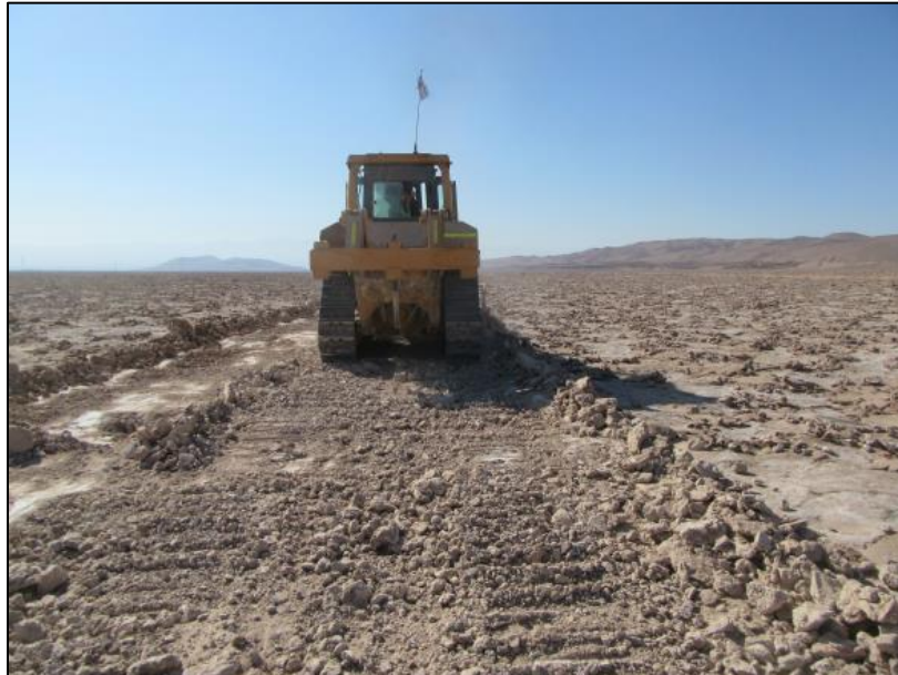
Figura 48. Camino de servicio en LAT. Bulldozer ensanchando camino.
