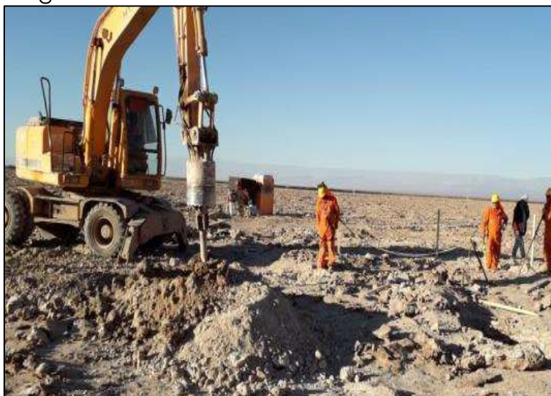
Figura 24. Camino LAT. Excavación de Torre 22.
