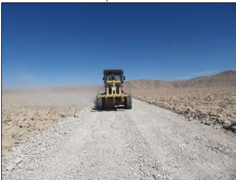
Figura 26. Moto niveladora perfilando contornos del camino.
