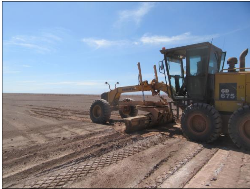
Figura 59. Parcela Oriente de GS. Inicio de escarpe para construcción de camino.
