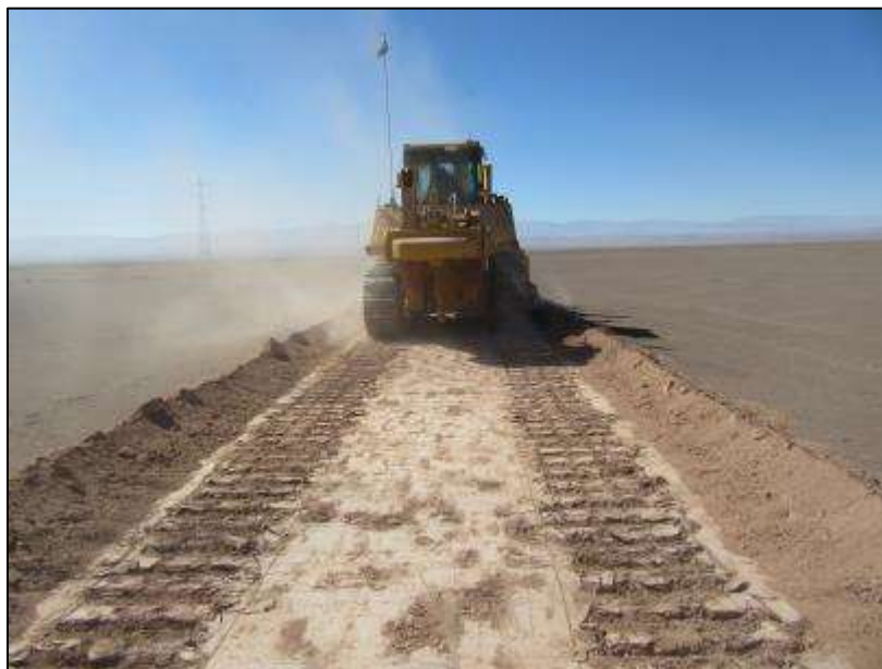
Figura 5. Frente de trabajo N°2, Tramo 03 camino LAT. Bulldozer en proceso de construcción de camino de servicio.
