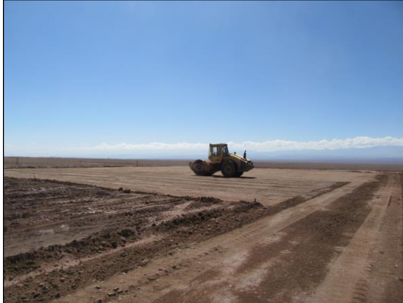
Figura 7. Rodillo compactador sobre plataforma para instalación de faena.
