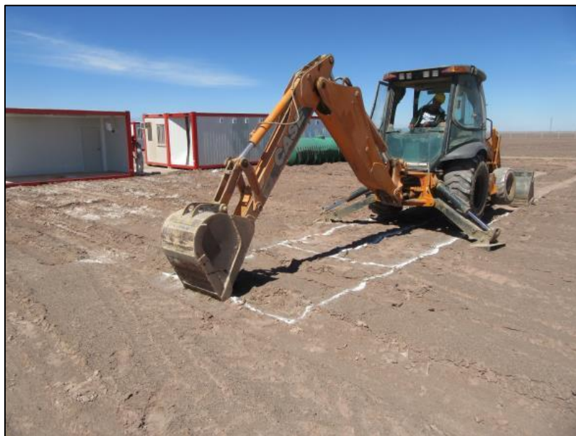
Figura 38. Parcela Oriente GS. Retroexcavadora iniciando excavación.
