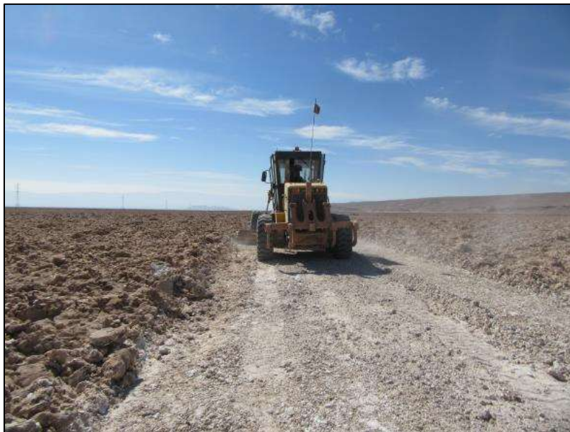
Figura 30. Moto niveladora interviniendo suelo natural para construcción de camino.
