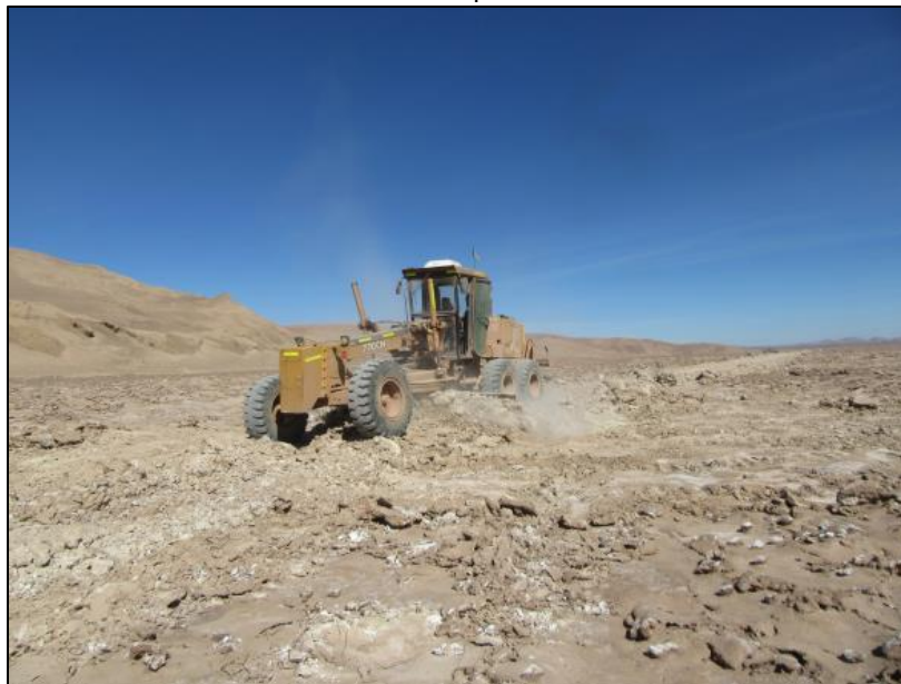
Figura 21. Camino de servicio en LAT. Motoniveladora distribuyendo material aportado.
