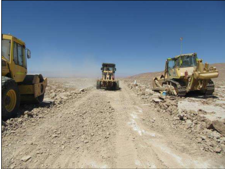
Figura 42. Moto niveladora operando sobre camino de servicio. Se observa en la Derecha Bulldozer fuera de servicio y a la Izquierda Rodillo compactador estacionado.
