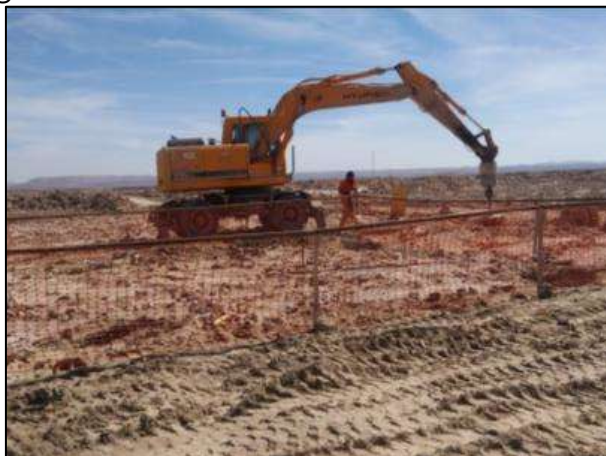
Figura 26. Camino LAT. Excavación torre 25.
