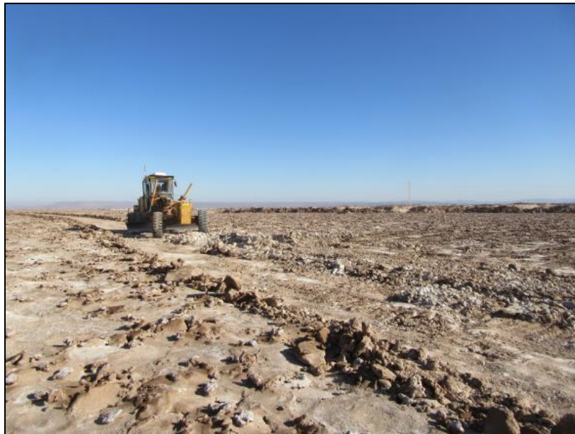
Figura 28. Camino de servicio en LAT. Motoniveladora distribuyendo aporte sedimentario sobre huella.
